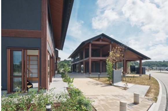
駅西住宅外観
