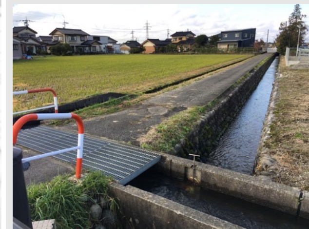
▲改良した用排水路
